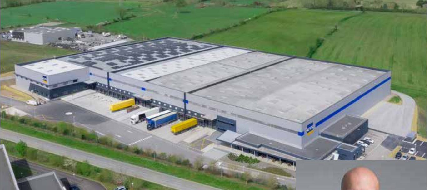
Die Lagerfläche von GYS umfasst mittlerweile 20.000 m 2 . Das Dach des Logistikgebäudes wurde mit Photovoltaikanlagen ausgestattet und ist seit Januar 2023, ebenso wie die Produktionsstätte, ISO 14001 zertifiziert.
