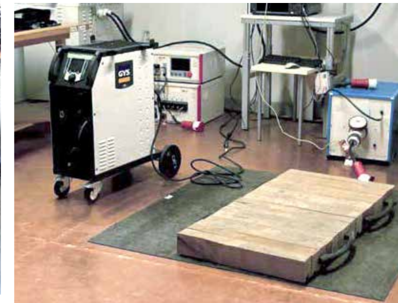
A área de teste de protótipos foi ampliada para agilizar o processo entre os projectos do gabinete de estudos e o arranque da produção. Esta área de cobre, na qual é testada a ausência de perturbações electromagnéticas causadas pelo gerador, será duplicada.
