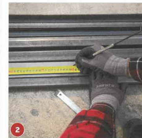
2 Die Länge der Schiene (hier: 480 cm) ergibt sich aus der Breite der Türen plus der Öffnung. Am Flachstahl anzeichnen.
