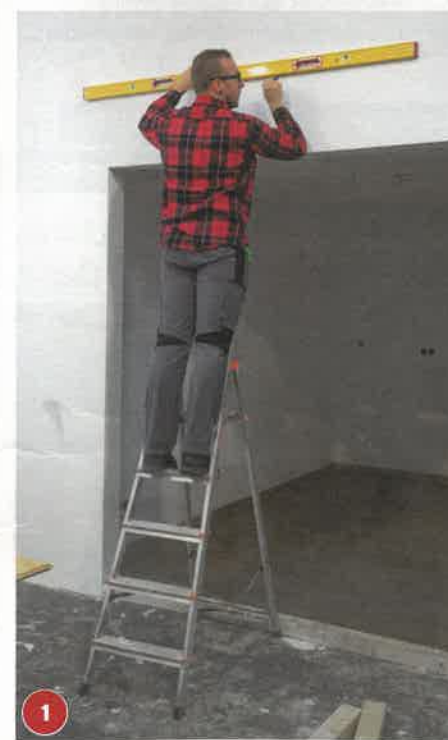
1 Türhöhe und Position der Laufschiene ermitteln und anzeichnen. Hier liegt die Schiene auf circa 265 cm Höhe.
