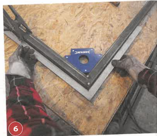
6 Trotz Schweißmagnet kann sich das Material verziehen. Nach dem Anheften nochmals prüfen und wenn nötig richten.
