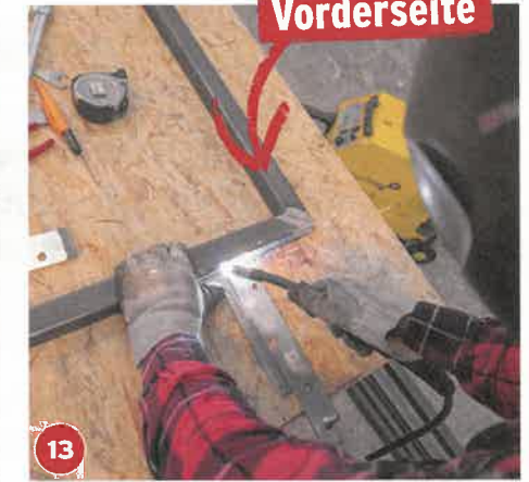
13 Vor dem Anheften muss die Verzinkung an den Bändern abgeschliffen werden. Sonst entstehen giftige Dämpfe!
